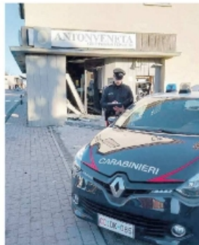
L'INTERVENTO carabinieri davanti alla filiale di Vo e di Camposodoro: gravi danni alle due strutture
